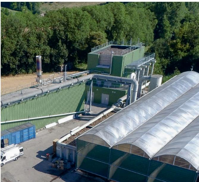
Les nouvelles installations permettent de mieux valoriser le biogaz produit et d'augmenter la quantité injectée dans le réseau, tout en produisant de l'électricité grâce à trois turbines à gaz. Ces dernières, associées aux panneaux photovoltaïques, produisent presque l'équivalent de la consommation énergétique du site.
